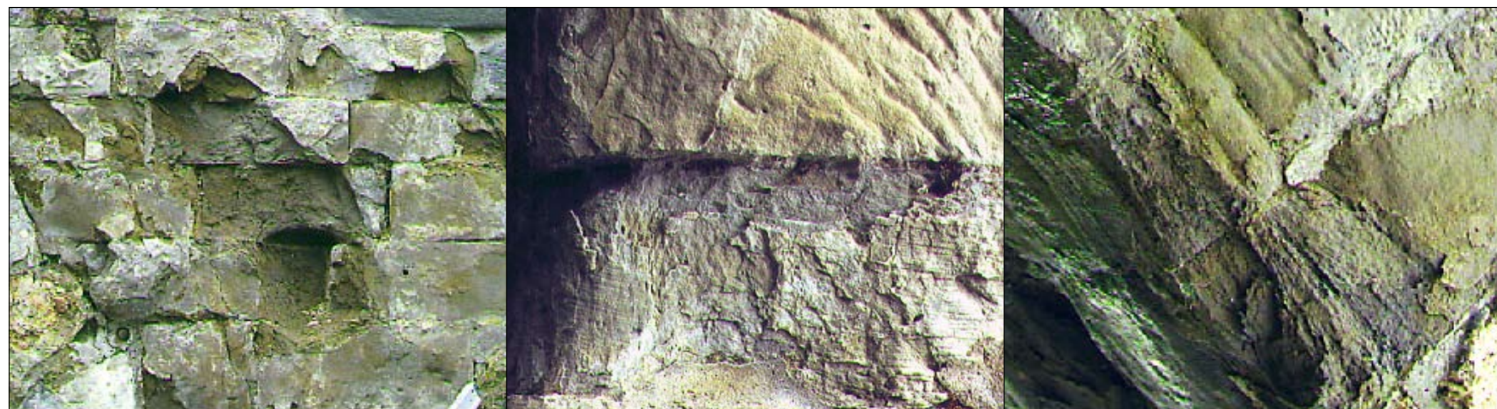
Feuchteaustritt aus der Lockerfüllung, dadurch Sandsteinverwitterung; von der Gesteinsqualität abhängige Abwitterungstiefe Gewölbekante: Versagen einzelner, stark verwitterter Mauersteine
