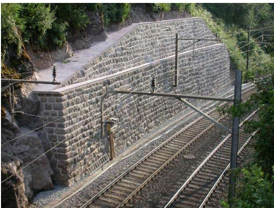
Bild 9: Beispiel einer Erhaltung und Sicherung einer Verkleidungsmauer (Mauerkronenabdeckung aus Beton, komplette 5-10cm tiefe neue Verfugung, verdeckte Sicherung mit Nadelankern im Fels)
