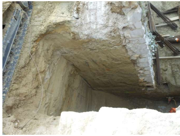
Bild 4: gleiche Mauer wie Bild 3 Sondierung: Verkleidungsmauer
