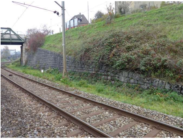
Bild 3: Mauer entlang Bahntrasse
